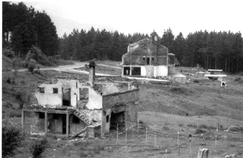
Vision très fréquente de maisons détruites. Ici au moins le déminage est en route (au sud de Sarajevo).
