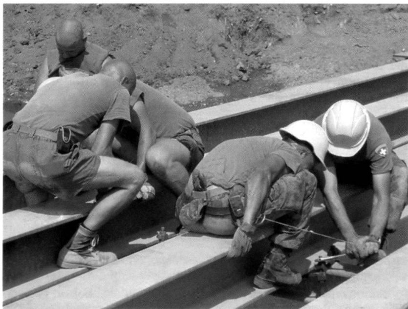
Des pionniers suisses travaillent sur le pont de Prestovo.
