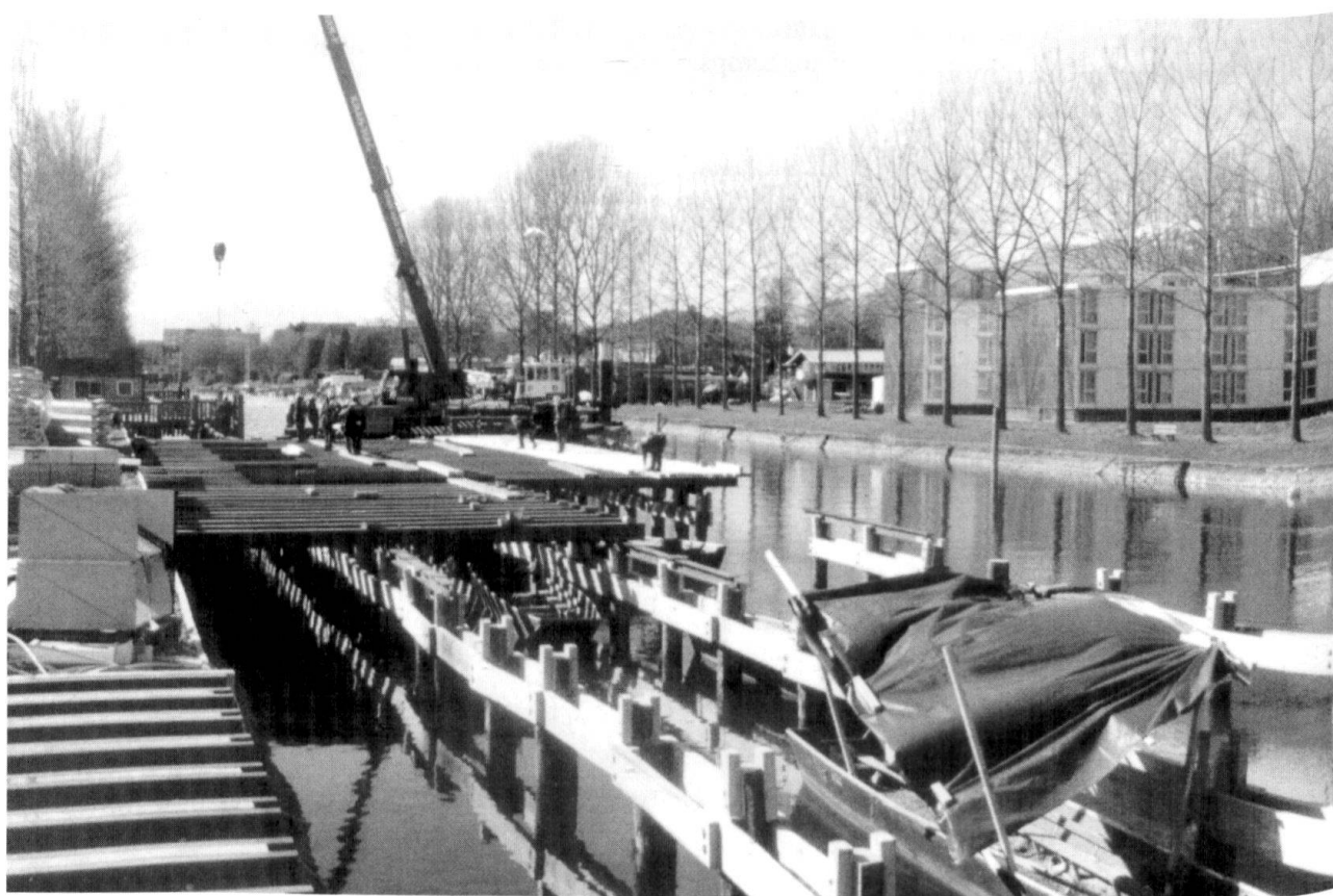
Finition du plancher.
