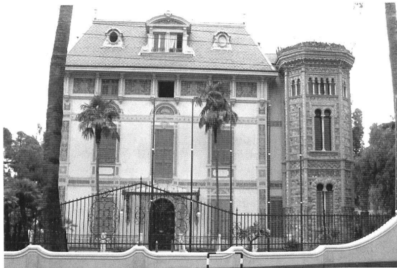
Le bâtiment de l'Institut.
