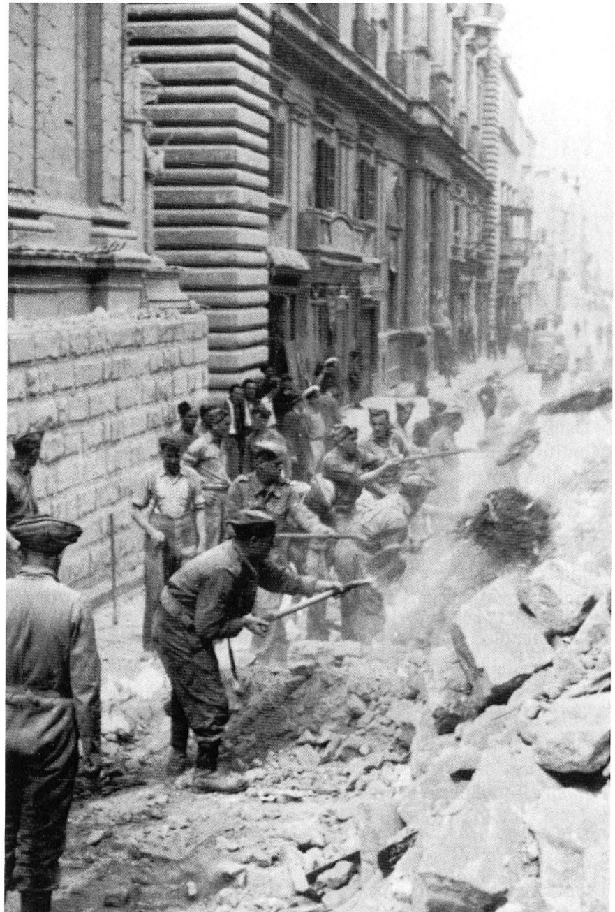
Soldats dégagant les décombres dans Kingsway, principale artère de la Valette, après un raid, pendant la Seconde Guerre mondiale.
