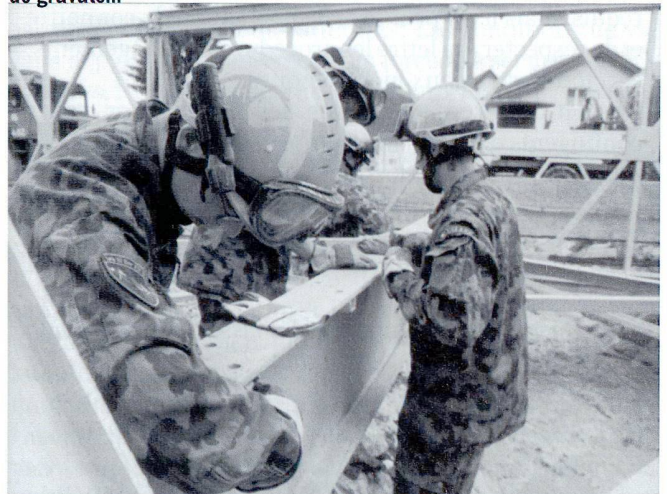
...ainsi que la construction de passages ou de franchissements.
