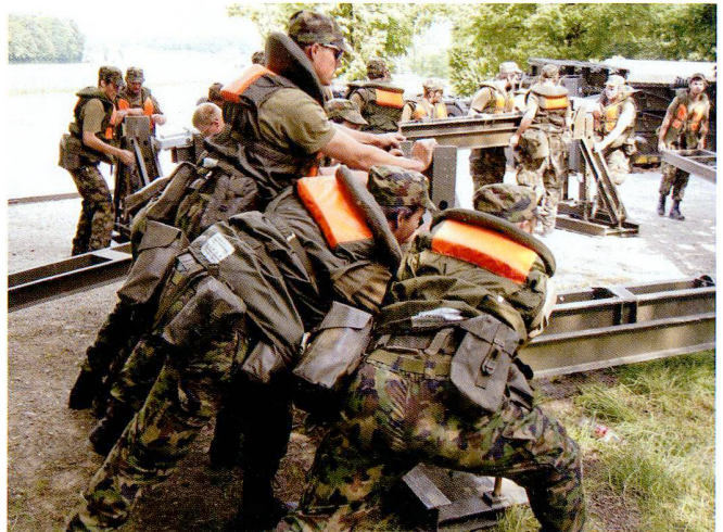
L'essentiel du travail de construction se fait à la main.
