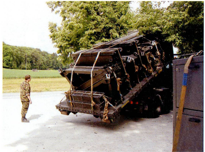
Les étapes de la construction du pont fixe 69. Les éléments du pont sont déchargés des camions.
