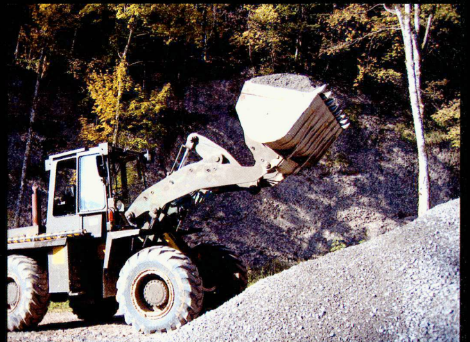
Les pelles mécaniques appuient l'engagement des sapeurs.
