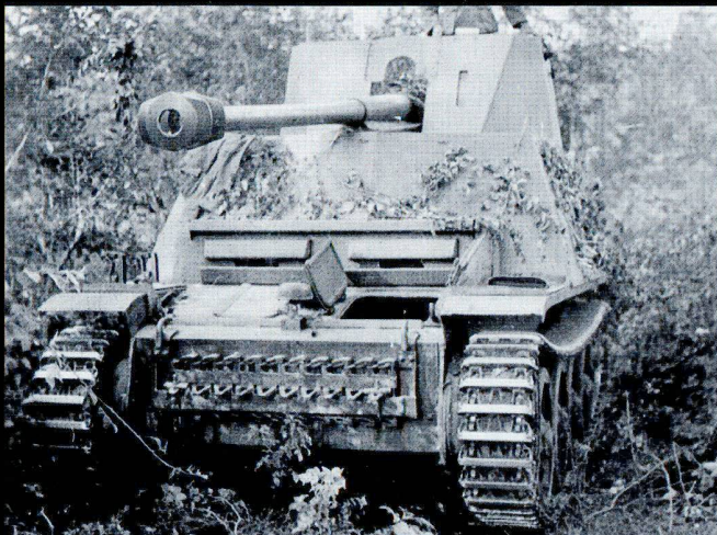
Confrontés aux chars soviétiques, les chars légers allemands doivent être réarmés et transformés en chasseurs de chars, à l'instar de ce Pz II.
