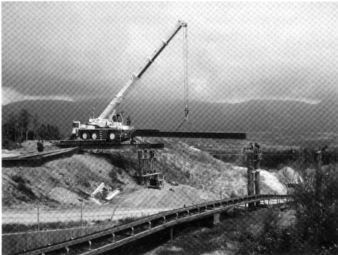
Construction d'un PPA à Arch.
