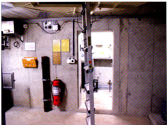
L'échelle amovible permettant d'accéder à la tourelle depuis le local central de l'ouvrage.
