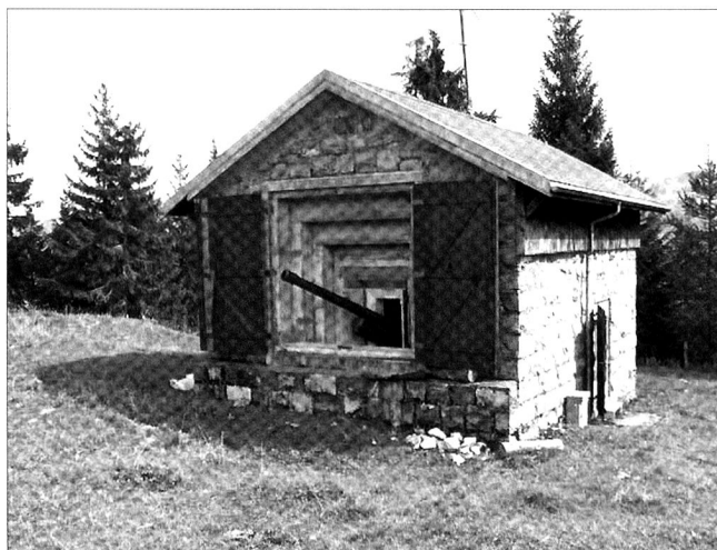
Afin d'améliorer le degré de protection, des infrastructures fixes ont été développées depuis le milieu du XIX e siècle. Ici, un canon de forteresse de 10,5 cm camouflé en forme de maison.
