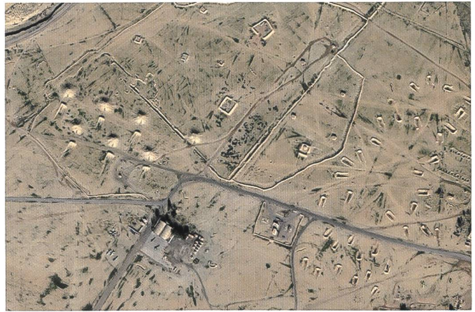
Tranchées, et positions de combat au nord de l'aéroport.
