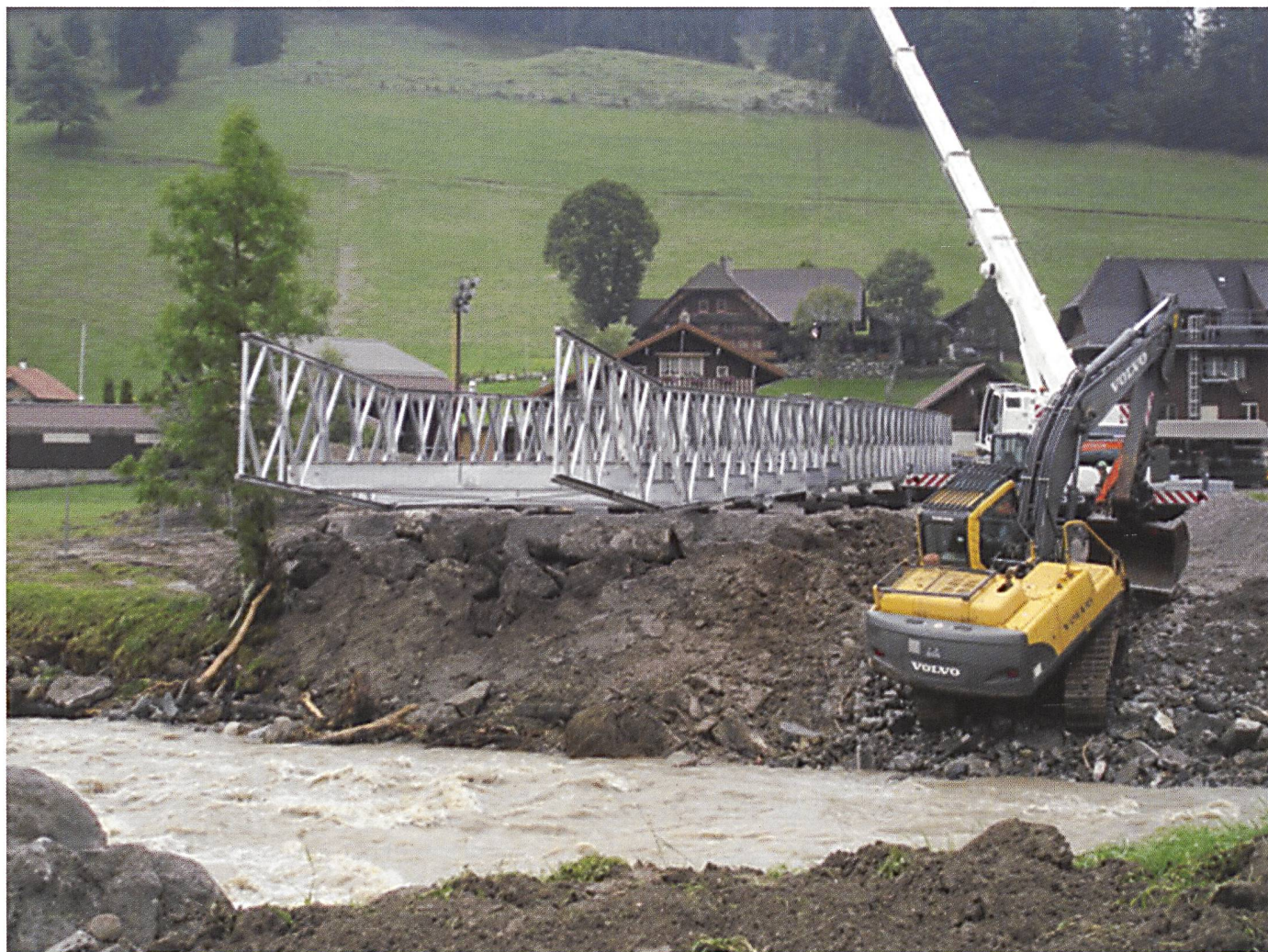
Construction d'un pont d'urgence de type Mabey en été 2014 à Bumbach (BE).
