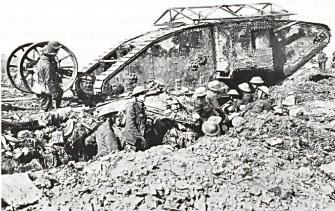
Un char Mark I « mâle » monte vers le front. On distingue, à l'arrière, les roues (ici en position levée) sensée aider aux changements de direction. Cette assemblage sera vite abandonné. La « cage de poules » au-dessus de l'engin a été conçue pour se protéger des jets de grenades à main.
