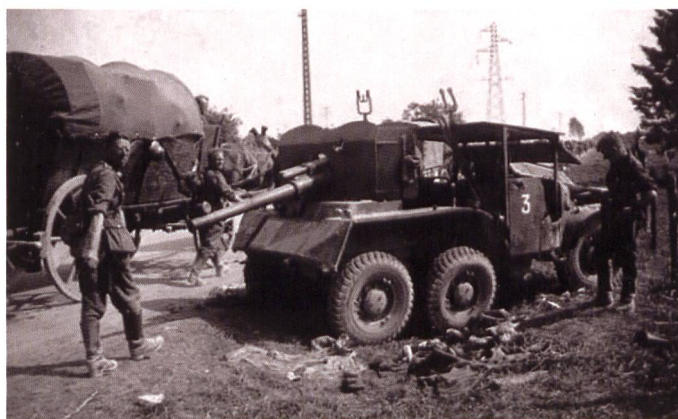
L'armée française a développé de son côté des canons antichars de 47 mm sur des camions Laffly W15. Au total, 70 engins ont été construits entre le 24 mai et le 17 juin 1940. A l'origine, l'engin devait disposer d'une cabine entièrement blindée mais celle-ci a été abandonnée. L'engin pèse près de 5 tonnes et est handicapé par sa hauteur.
