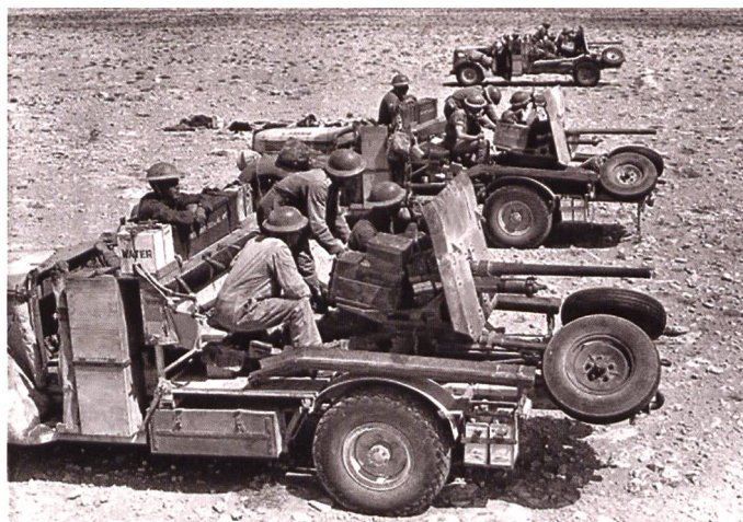
L'armée britannique a expérimenté avec la fixation de canons d'infanterie ou antichars sur les camions tracteurs, surnommés « portees » et permettant ainsi de réduire le temps de mise en batterie. Ces canons de 2-lbs ou 40 mm ont été installés en atelier sur des camions Chevrolet. Ces engins sont les ancêtres des « technicals » contemporains.
