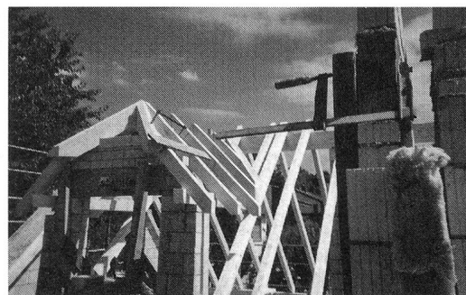
Von Katinka gezimmerter Dachstock.
