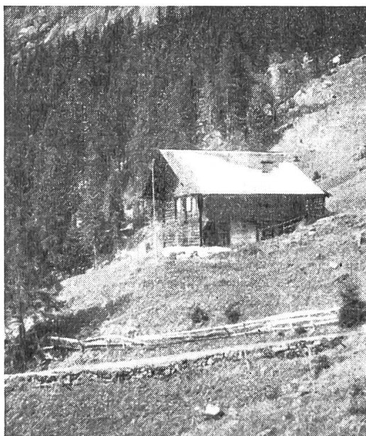
Die Büttthütte von der Alpgasse aus gesehen
