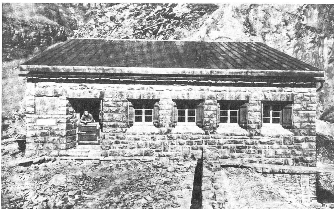
Die neueste Gspaltenhornhütte, Ansicht von vorn
