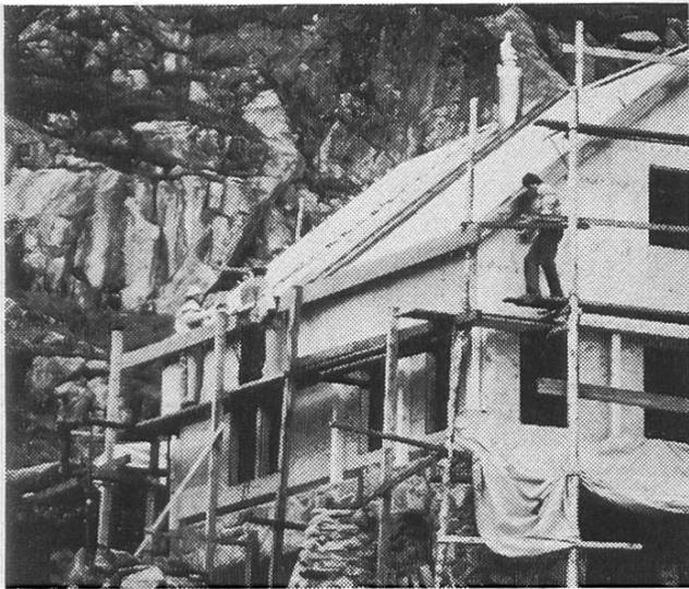
Kosten und weil gut vermauerbarer Naturstein am Ort nur ungenügend vorhanden war, fiel der Entscheid für diese leicht zu transportierende Bauweise. Die Fassaden aus sägeroher Holzschalung und ein Kupferblechdach mit integrierter Blitzschutzanlage schützen den Bau vor dem rauen Bergwetter.
