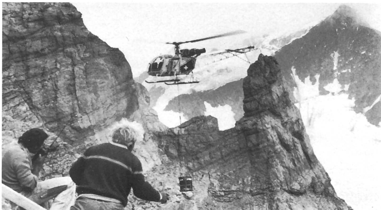
Betonflug Titlis Südwand
