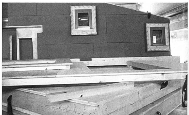
Bereitgestellte Holzelemente.
