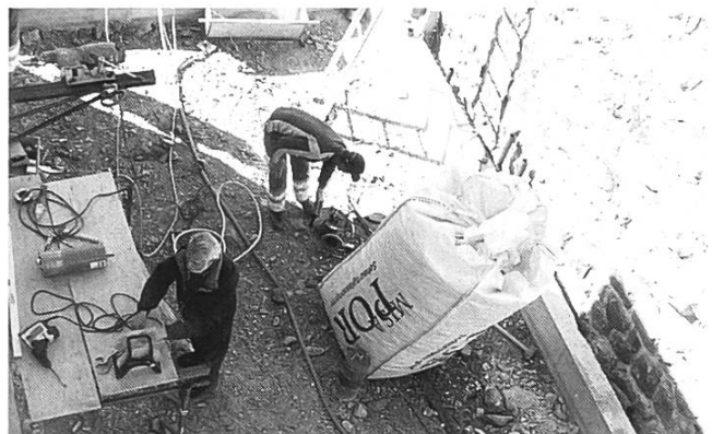
In diese «Lücke» kommen die Holzelemente.
