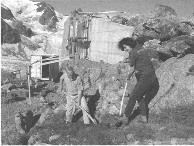
Irène und Erwin schaufeln am Graben für die Blitzableiter
