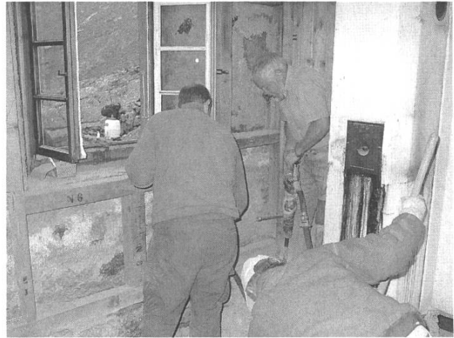
Erwin am Kompressor spitzt den alten Betonboden weg
