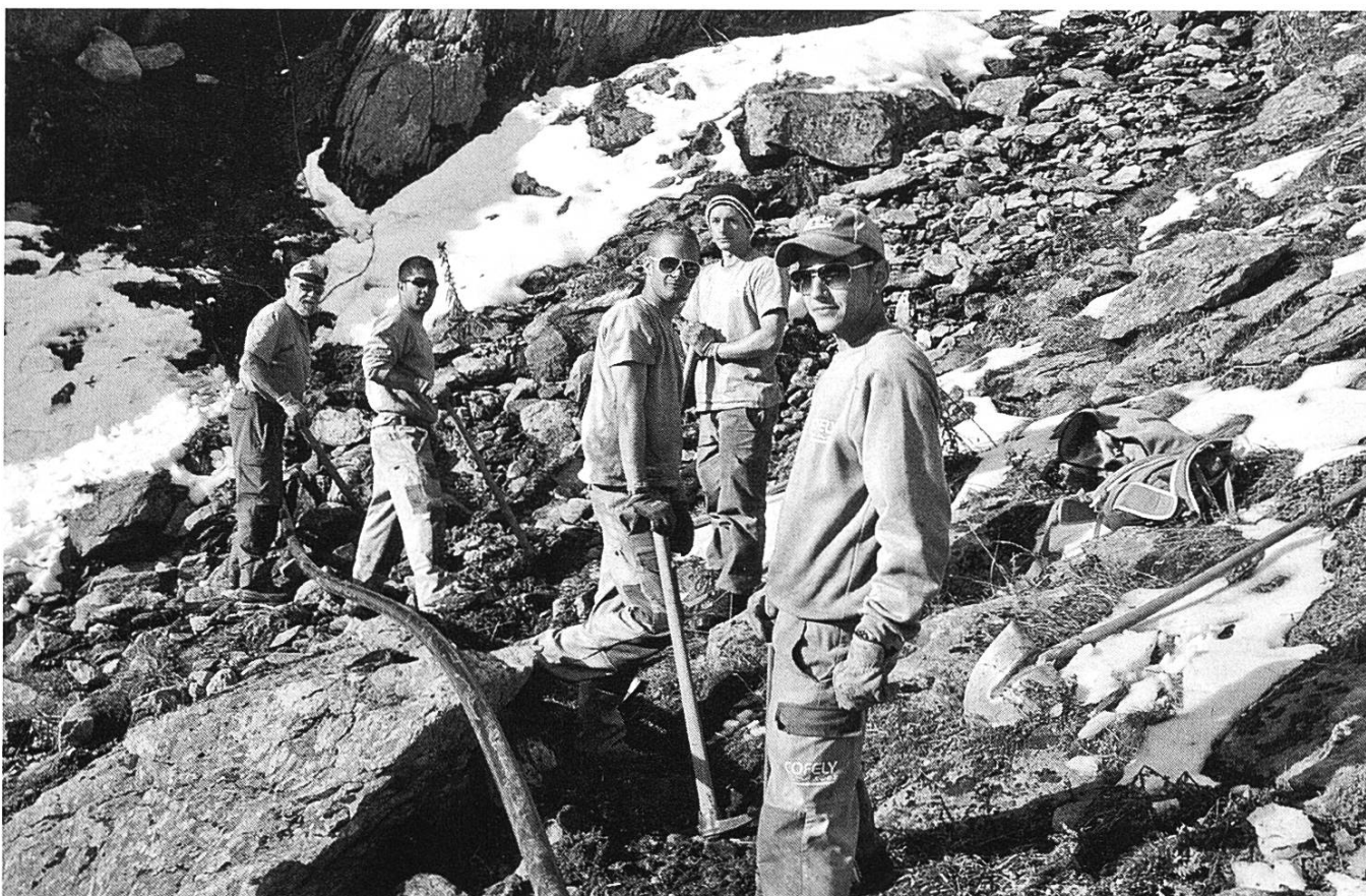
Die Lernenden von «Cofely» bei den Grabungen für die Rohrleitungen
