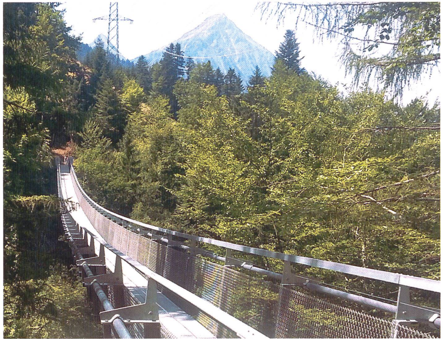
Spissibach-Hängebrücke bei Leissigen.
