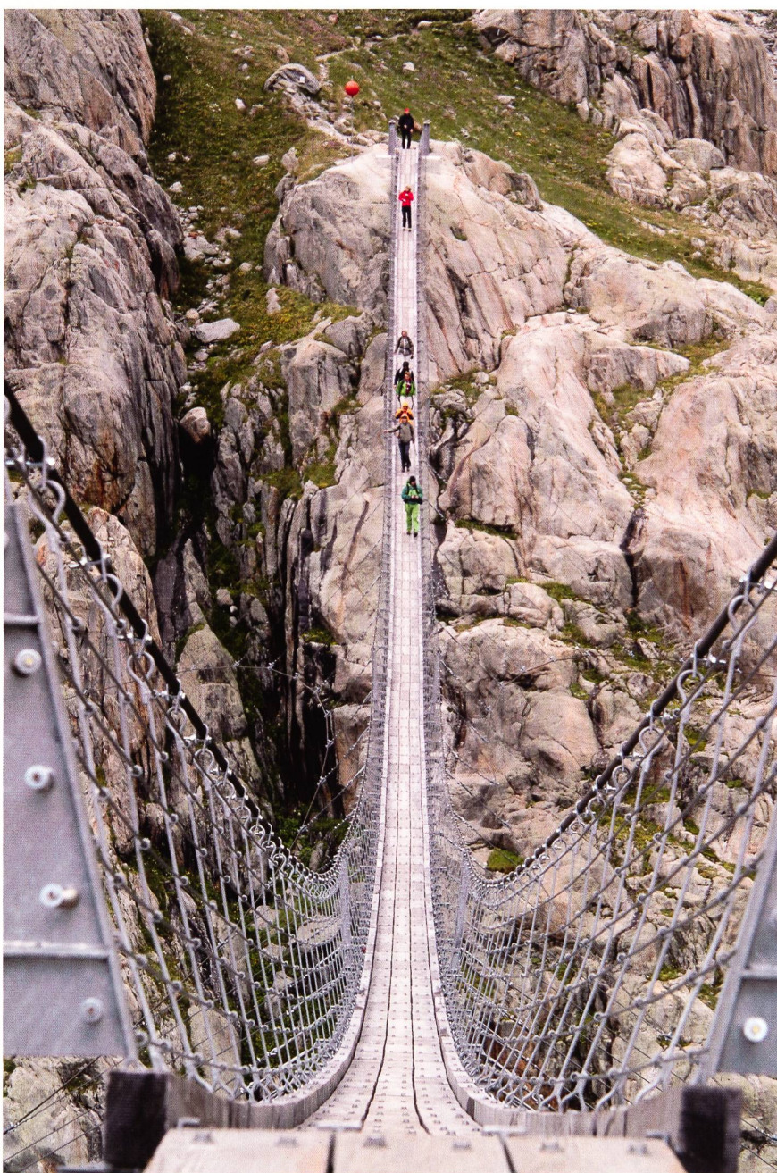
Die Trifthängebrücke – eines unserer vielen Markenzeichen.
