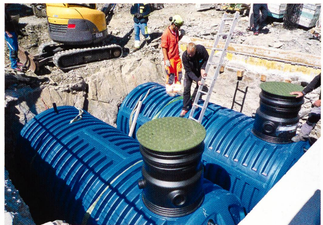
Die beiden Wassertanks à je 12500 l sind versetzt, der Flughelfer und Walter Brog packten tatkräftig zu.
