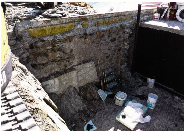
Der Hohlraum für die beiden Wassertanks ist erstellt. Rechts im Bild die Rückwand des neuen Lagerkellers mit dem schwarzen Isolationsanstrich.
