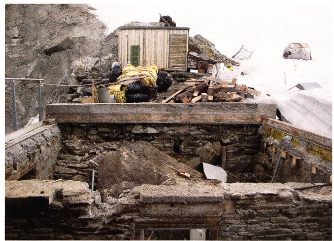
Diese alten Mauern sind vermutlich die Überreste der ursprünglichen «Egon von Steiger Hütte».
