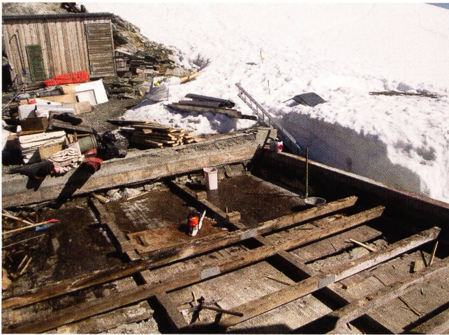
Abbruch der alten Kellerdecke durch die Hüttenwerke.
