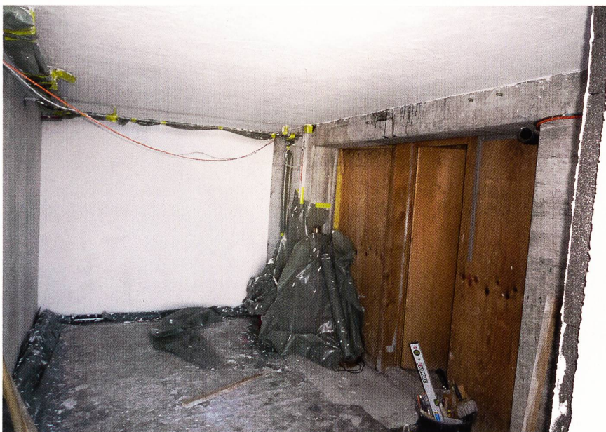
Innenansicht des neuen Lagerkellers.
