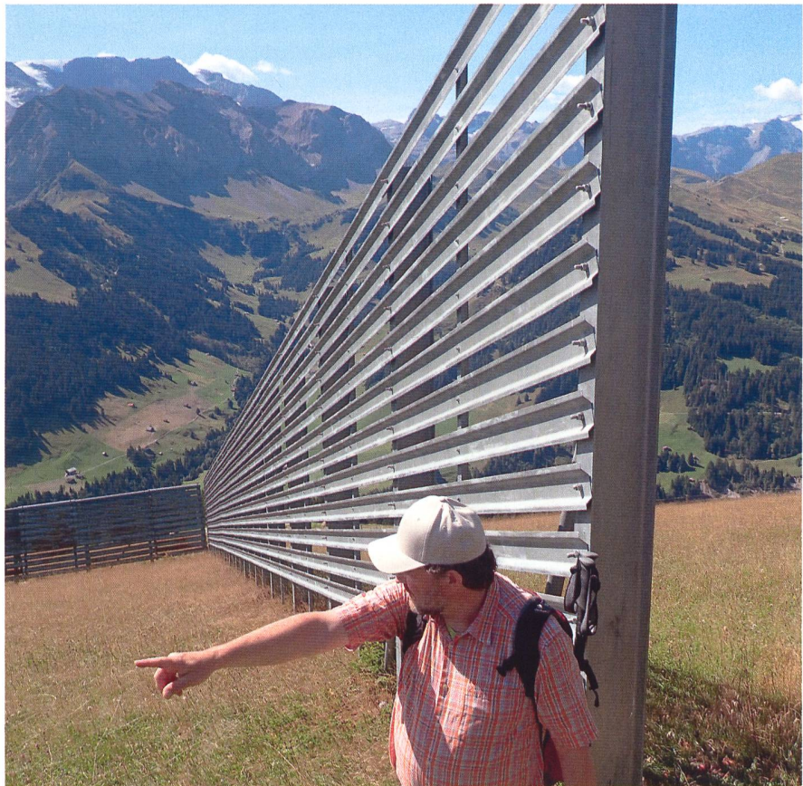
Der im Zickzack aufgebaute Triebsschneezäun unterhalb des Schwandfälsplatzes. Die reduzierte Windgeschwindigkeit führt zur gezielten Ablagerung von Triebsschnee.
