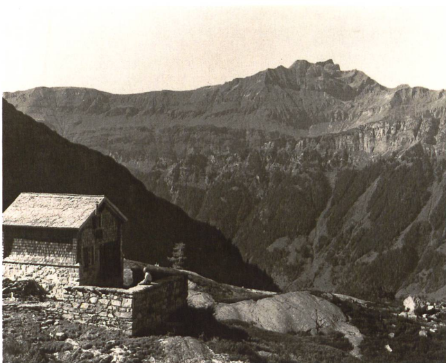
Die 1891 von Melchior Bossli erbaute alte Windegghütte wurde 1925 zum heutigen Standort versetzt.
