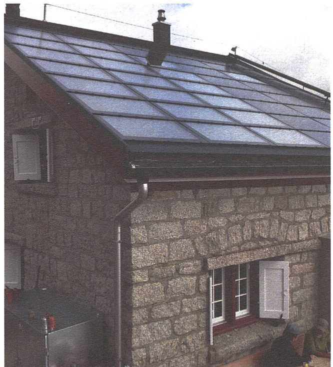
Ansicht Systemdach Albert Heim-Hütte. Bild: zVg.
