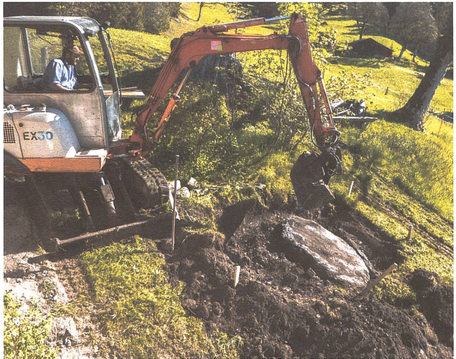
Nachbar Toni beim Baggern.
