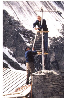
Dem Himmel nahe – Bauprovisorium auf dem Dach der Hollandiahütte.
