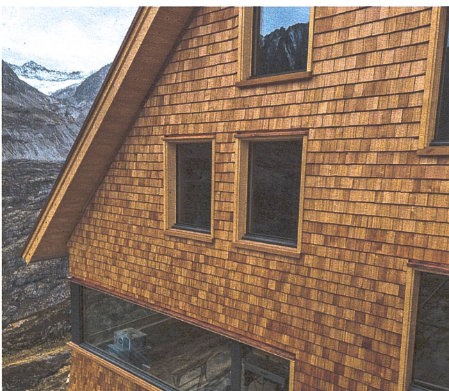
Neue Fassade aus Holzschindeln
