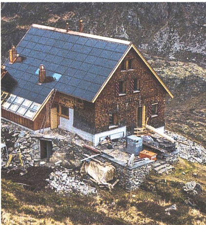
Aussenaufnahme mit neuem Dach und neuer Fassade
