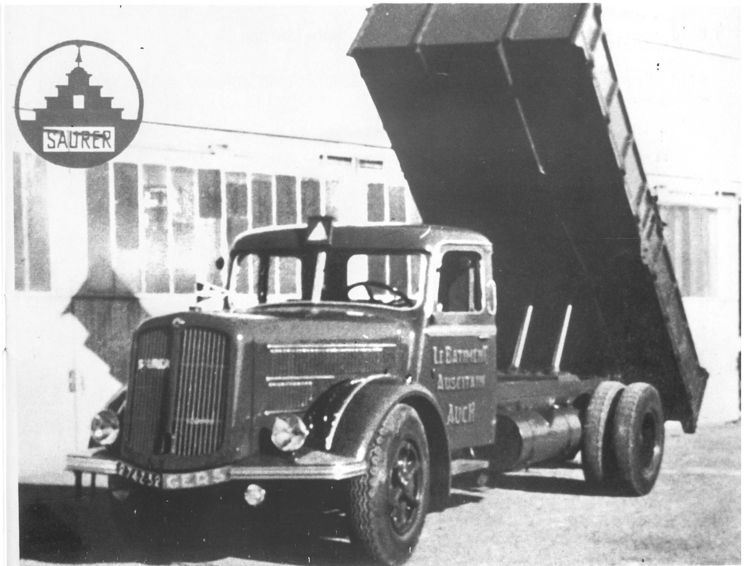
Bild unten: Saurer 8BUD 6 Baujahr 1953 mit Bourrec-Kipper
