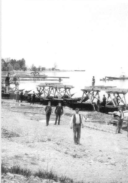
VERLEGEN DER SEELEITUNG
