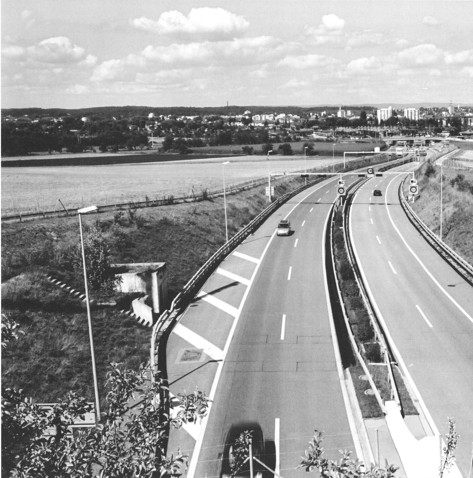
Der neue Autobahnzoll Tägermoos ist so konstruiert, dass er jederzeit in Einzelteile zerlegt werden könnte. Als ob die Aussichten auf einen EU-Beitritt der Schweiz gross wären. Bild: Adrian Elsener
