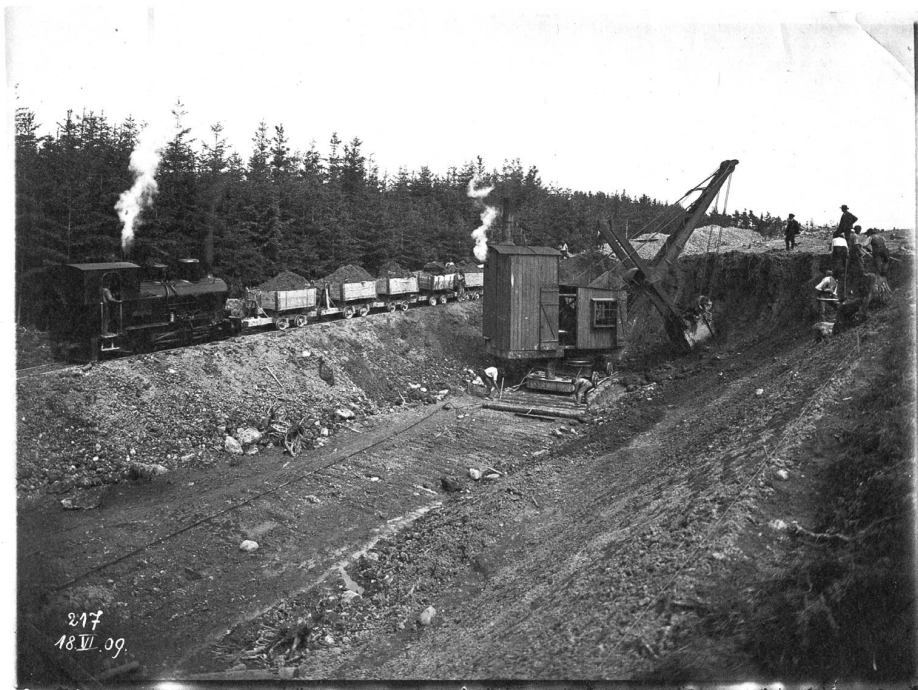
Löffelbagger an der Arbeit in der Nähe von Roggwil.
