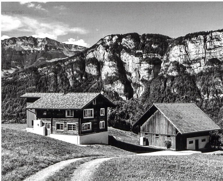
Beim Umbau «Schöfzig» wurde ein Strickbau aus dem Jahr 1778 in seinem Ausdruck erhalten. Die Dämmung wichtiger Bauteile kann die thermischen Schwächen alter Konstruktionen hinreichend kompensieren.
