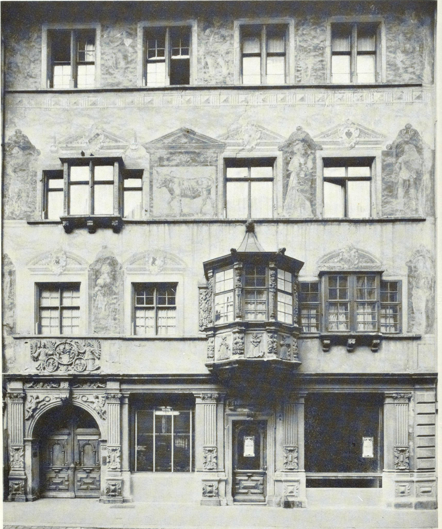
Die Fassade des Goldenen Ochsens unmittelbar vor der Renovierung
