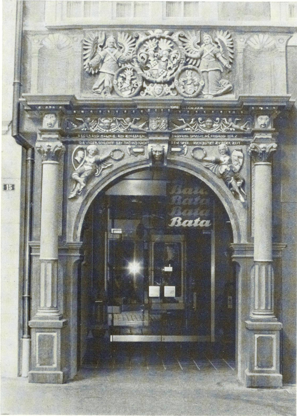
Das Portal mit den rekonstruierten Säulenvorlagen
