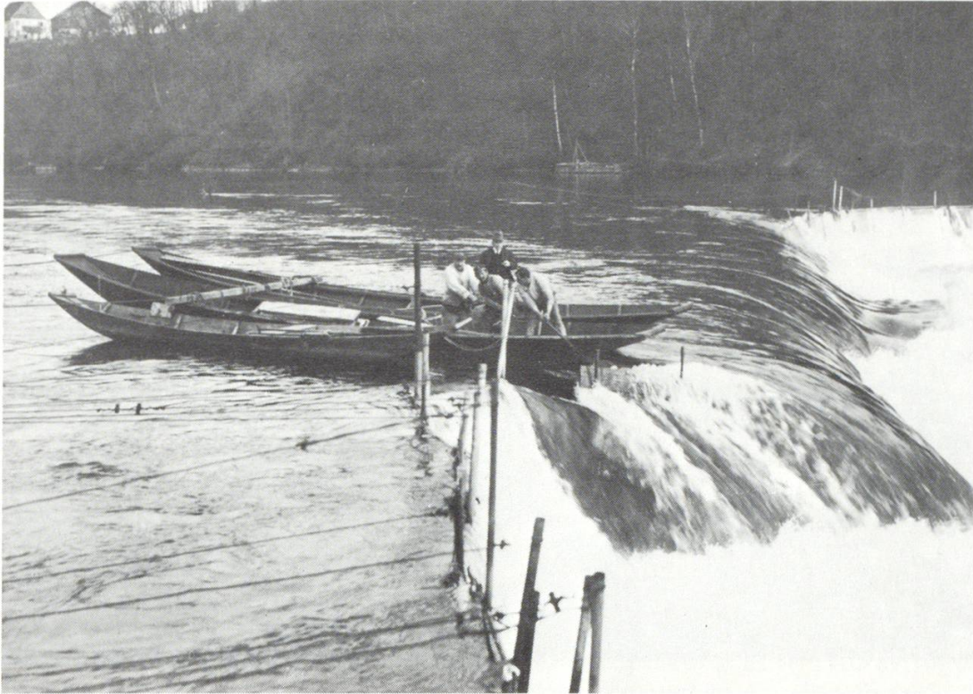
Stauarbeiten am Moserdamm (bis 1960)
