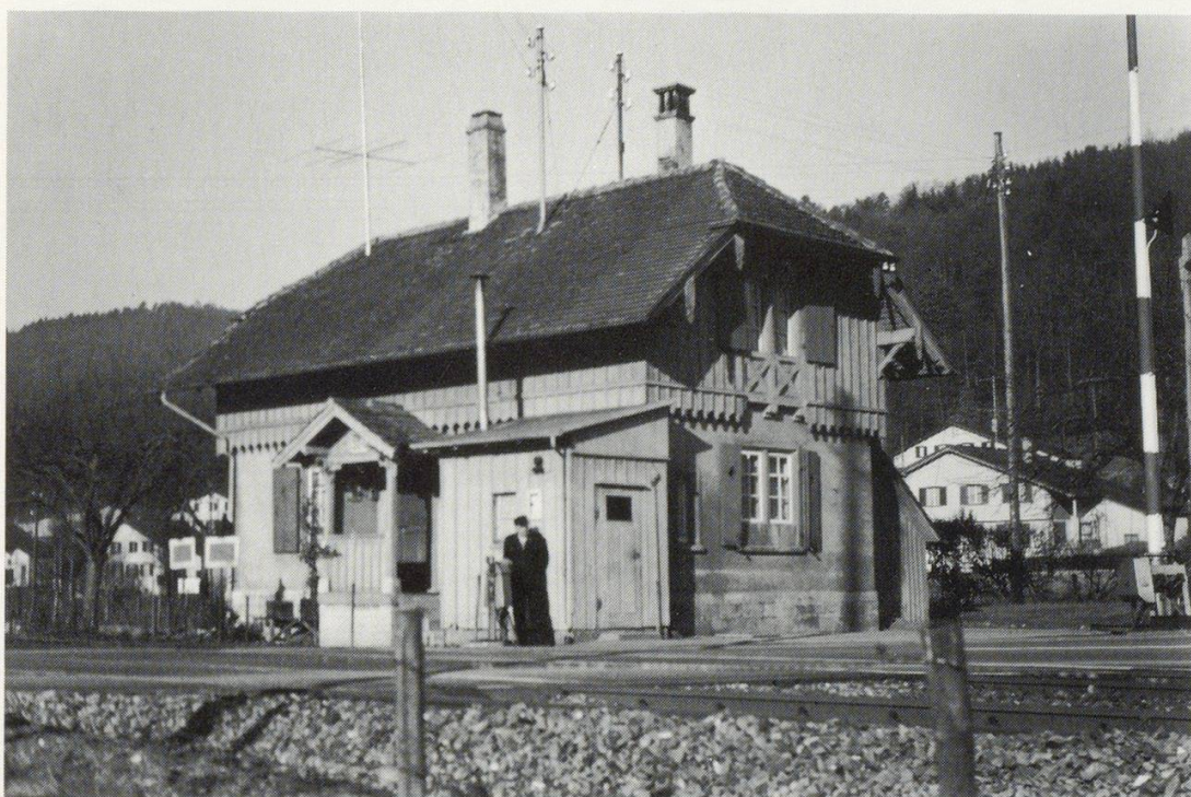
Abb. 5 Die «Bahnwart-Station» Nr. 504 beim Wirtshaus «Engebrunnen» an der Strasse nach Guntmadingen und Neunkirch im Jahre 1961. Aufnahme von Hermann Werner (1896–1975).
