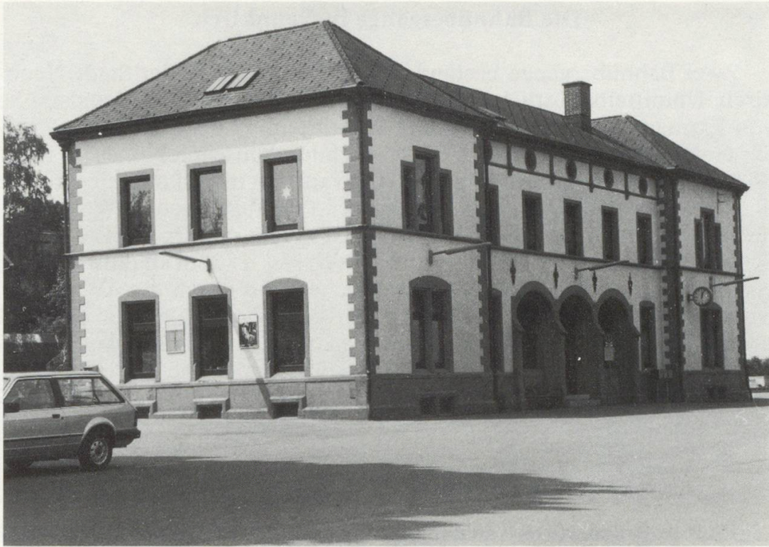
Abb. 3 Das Aufnahmegebäude der DB in Neunkirch, wie es sich heute präsentiert. Aufnahme: Rolf Baumann
