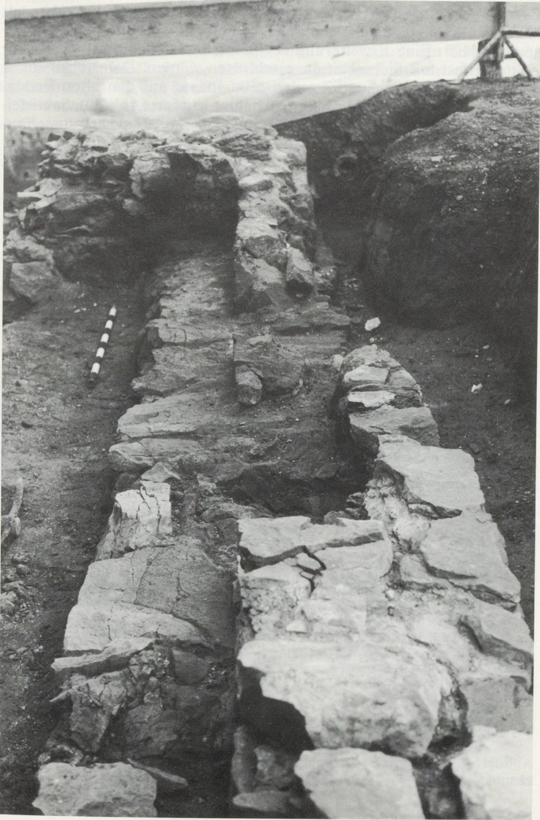
Abb. 10 Sakristeianbau. Fundamente des älteren Baues mit aufgehendem, teils versetztem Mauerwerk des jüngeren Gebäudes (Ansicht von Osten).
