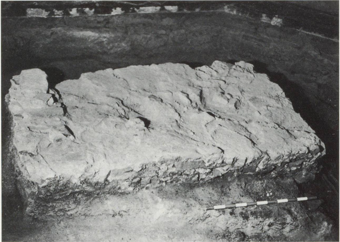
Abb. 5 Fundament des Hochaltars von 1491.
