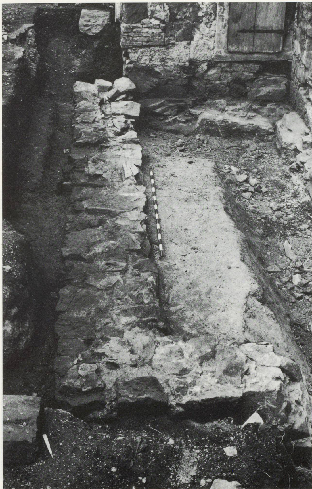
Abb. 9 Sakristeianbau. Fundamente des älteren Baues (Ansicht von Westen).
