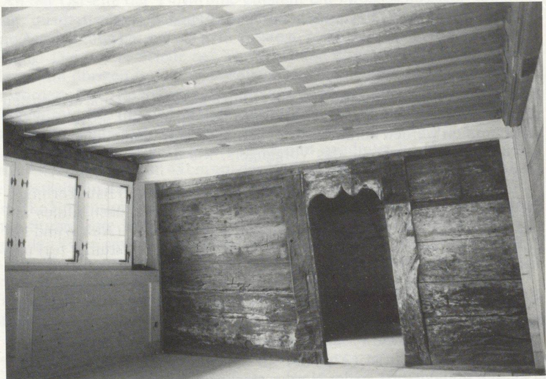
Abb. 5 Spätgotische Stube von 1467 mit Bohlen-Bälkchendecke und Bohlenwänden während der Restaurierung.
