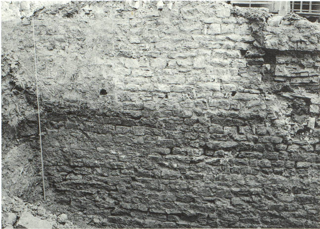
Abb. 32 Ansicht der Stadtmauer Bereich Bahnhofstrasse 56. Links oben der Verputz des 17. Jahrhunderts. Rechts oben ist dieser Verputz für die Maueruntersuchung entfernt worden. Die Unterkante der Messlatte am linken Bildrand bezeichnet das Niveau des ehemaligen Stadtgrabens. Er ist bis ins 17. Jahrhundert etwa 1,2 m hoch aufgefüllt worden (dunkle, untere Mauerfläche).
