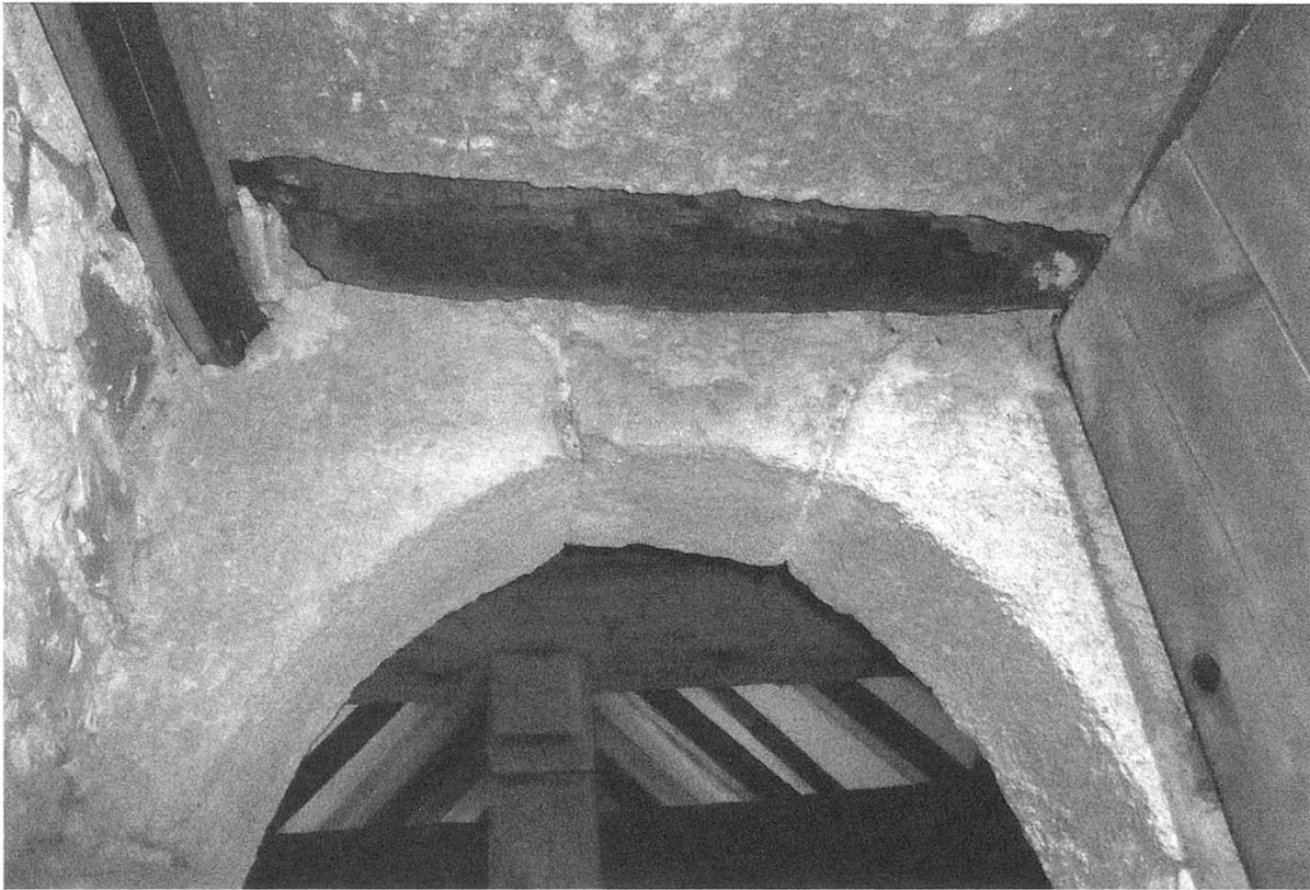
Abb. 8: Türe vom Schiffdachstuhl in den Turm mit angekohltem Holzbalken aus der Zeit um 1270.
