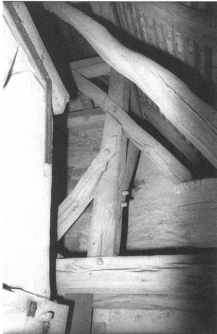
Abb. 10: Blick in das Turmdach das 1500 bis 1501 nach dem Schwabenkrieg mit dem Glockenstuhl neu aufgebaut wurde.
