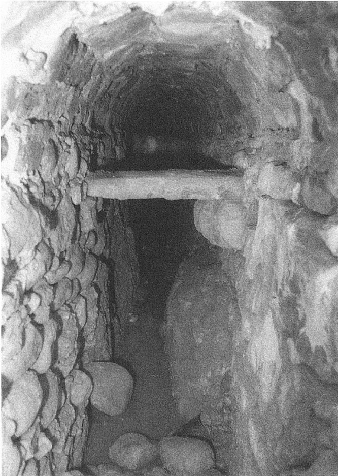
Abb. 7: Blick in den älteren mittelalterlichen Wasserfassungsstollen im Sandacker.
