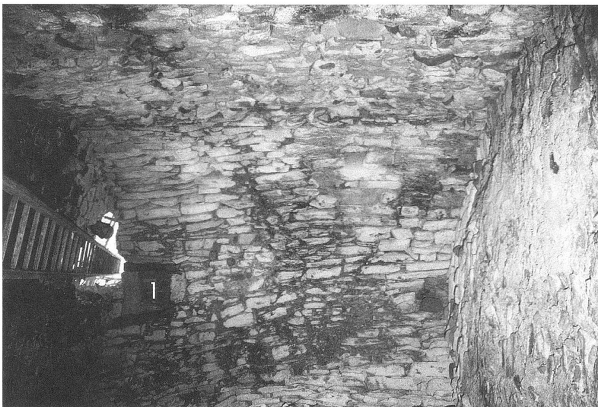
Abb. 12: Blick vom Latrinensboden hoch zum neuzeitlichen Latrinengewölbe mit vermauerter Einstiegsöffnung (1), Vorgasse 69.
