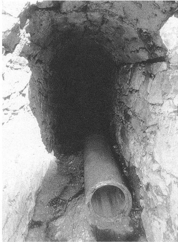
Abb. 14: Überwölbter Abwasserkanal aus dem 16./17. Jahrhundert mit modernem Zementrohr im Rüdenareal.
