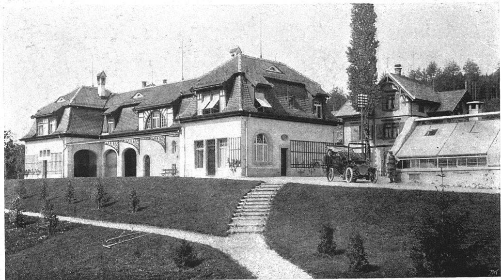
Stallgebäude und Treibhaus
