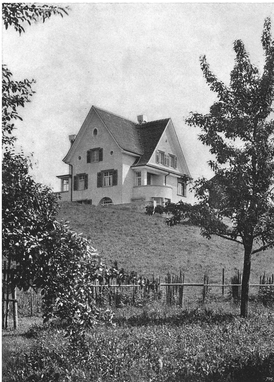
Blick auf die Süd- und Westfassaden Photographie von P. h. & C. E. i n f., Zürich I
