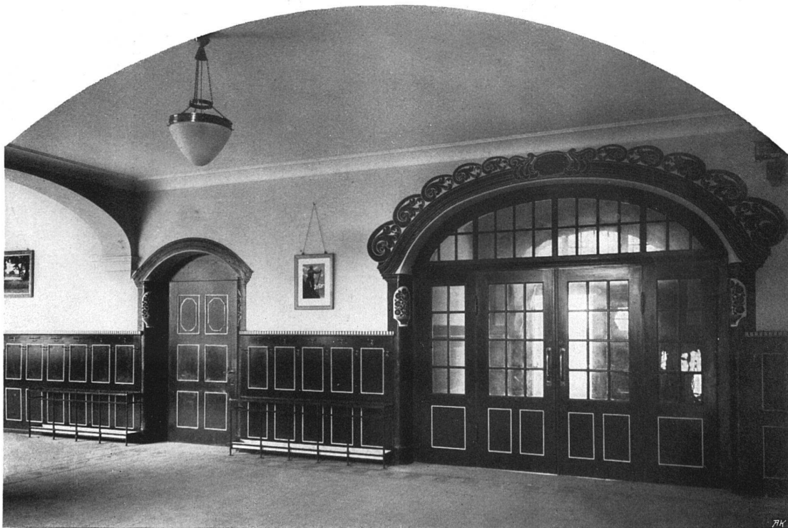
Große Windfangtüre der Erdgeschosshalle. — Bemalung wie oben angegeben Architekten B. S. A. Keiser & Bracher, Zug
